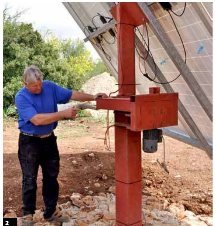
2 Die Nachführung für die Modultracker hat der gelernte Metallbauer selbst konstruiert und gebaut. Die Tische werden der Sonne einachsigt nachgeführt. Aufgrund der südlichen Lage und der verschattungsfreien Installation ist der Ertrag sehr hoch.
